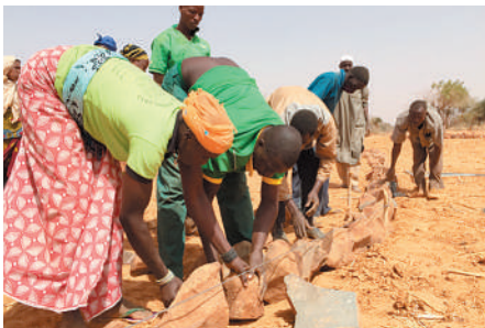
Steinkordeln bieten Schutz vor Erosion
