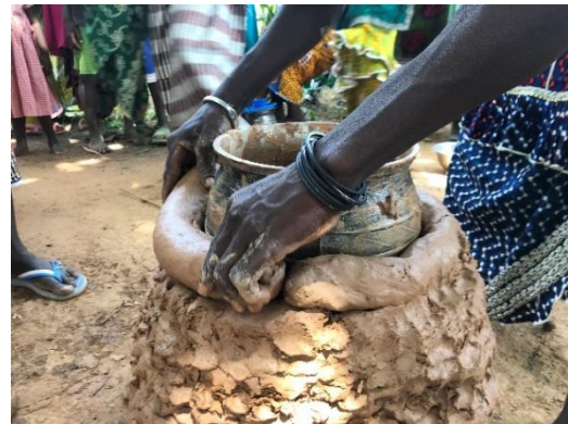
Bau einerholzsparenden Kochstelle
